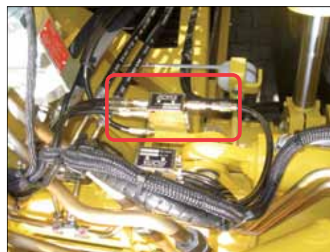
Huvudfördelare upptagare och blastare
