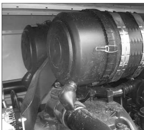
Dammutmättningsventil i korrekt position
