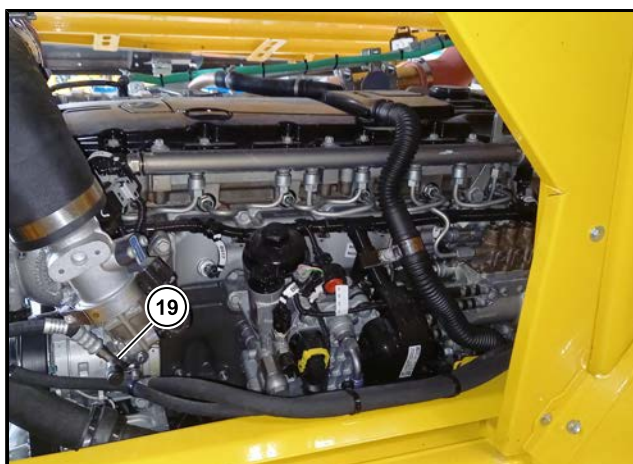
(19) Raccord de maintenance sur le compresseur de climatisation
