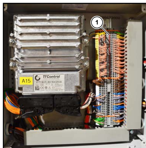
LED nella scatola elettrica dell'estirpatore
