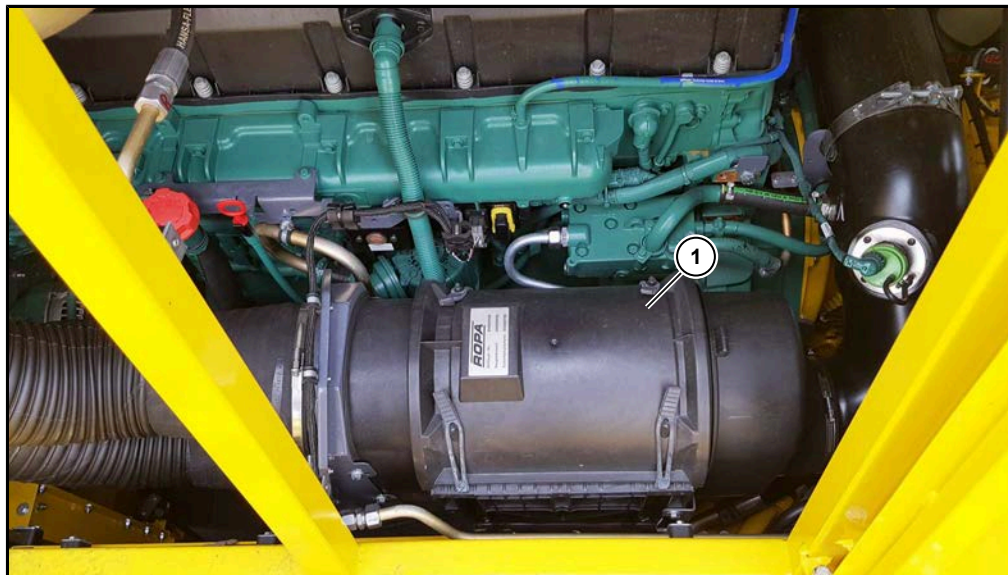
(1) Filtru de aer uscat
